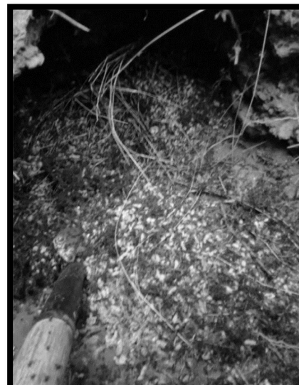
Figura 6. Excavación de tierra. Fuente: Angeles, N (2021)
