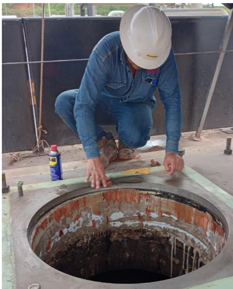
Imagen 2. Nivelación base plate
