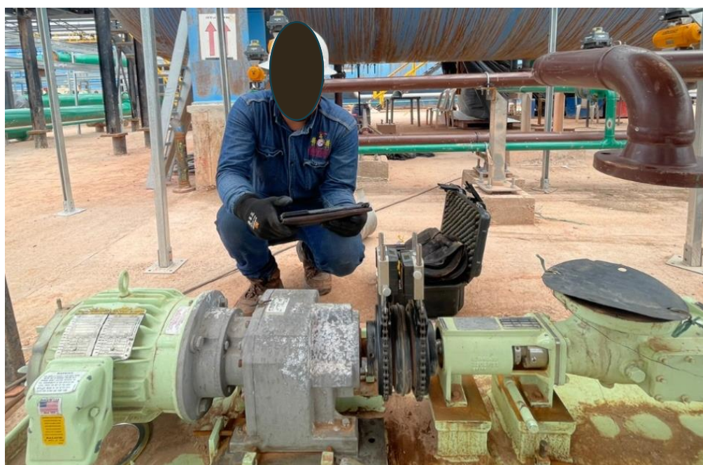
Imagen 1. Alineación de máquina fija
