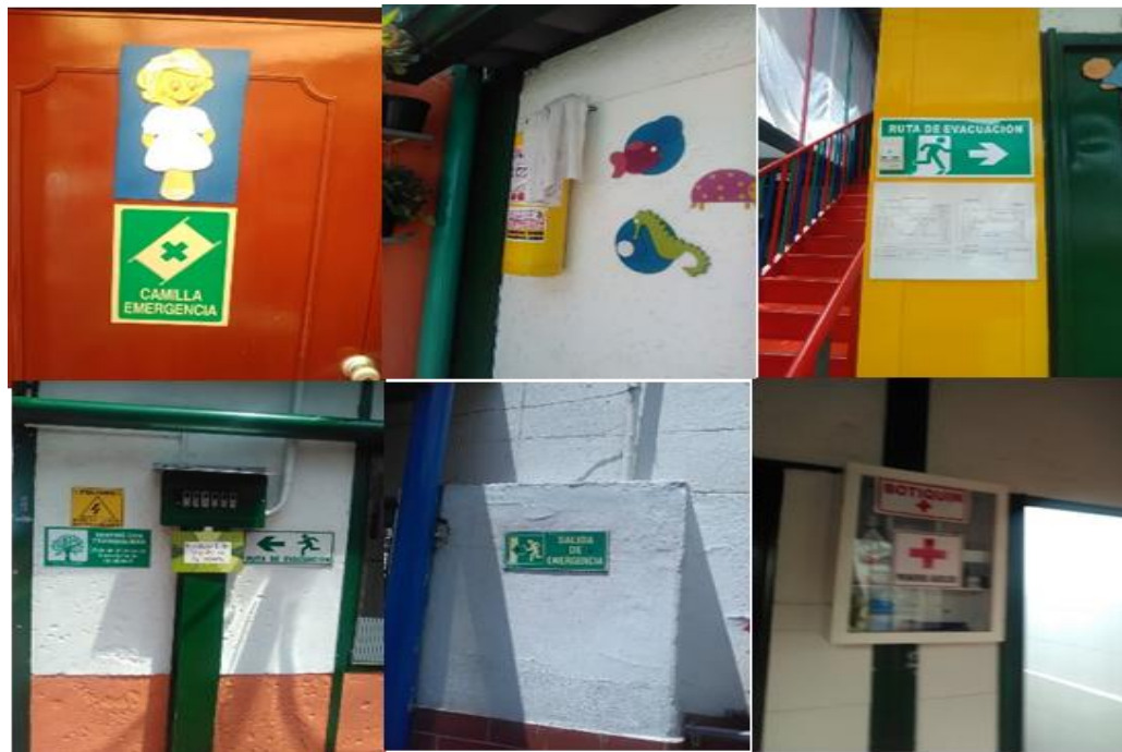
Imagen 2. Evidencia señalética y equipos de emergencia de la institución.
