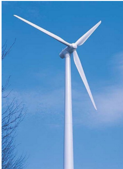
Figura 2. Aerogenerador de tres palas.
